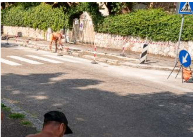
Lavori in corso Un cantiere in via Lega Veronese
