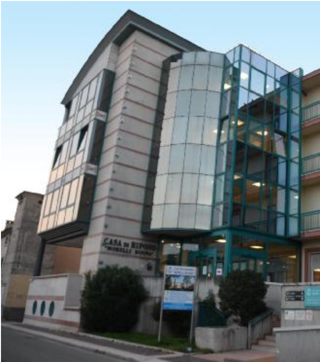
Casa di Riposo L'ingresso in via Rinaldo da Villafranca
